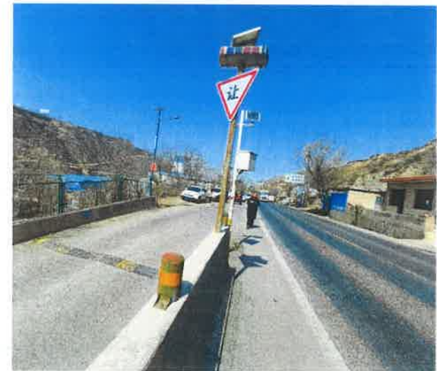
图 3 减速让行标志无匹配标线
