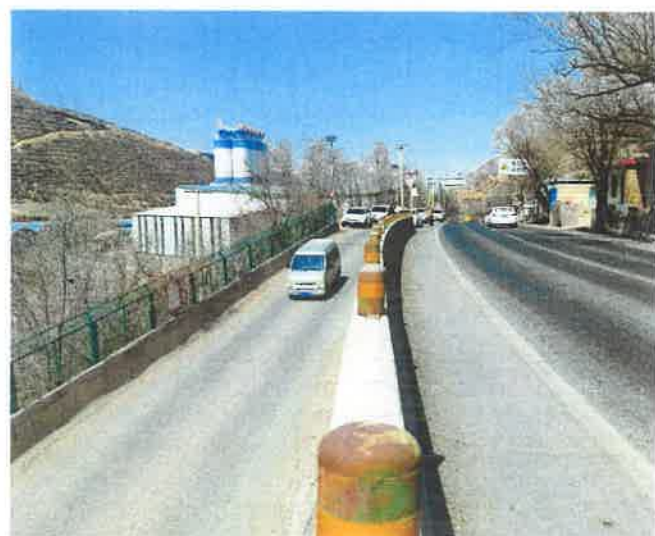
图 4 主线、被交道路未设置平交路口标线
