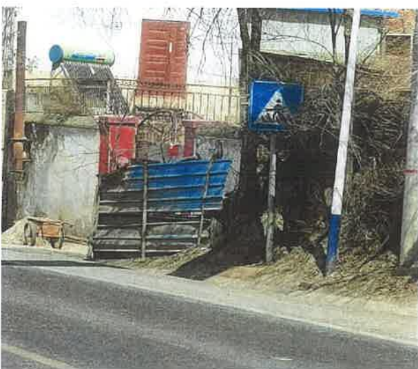
图 1 人行横道标志遮挡、无匹配标线
