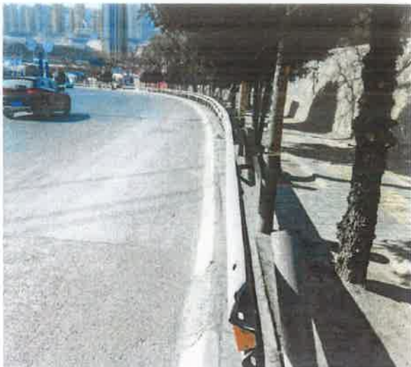
图 4 路侧护栏端头缺失
