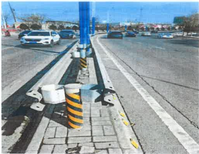
图 3 中分带护栏端头缺失
