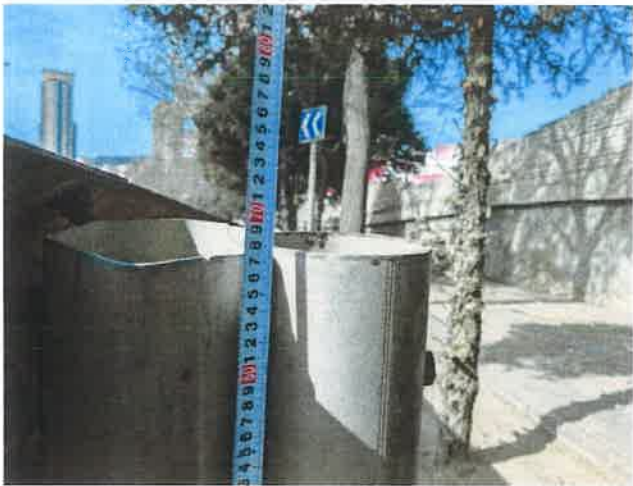
图 3 护栏立柱高度测量
