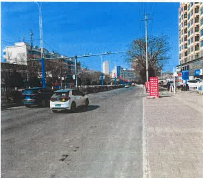
图 2 部分路段缺少隔离栏杆
