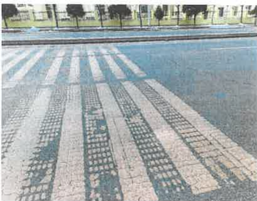
图 2 车行道横向减速振动标线
