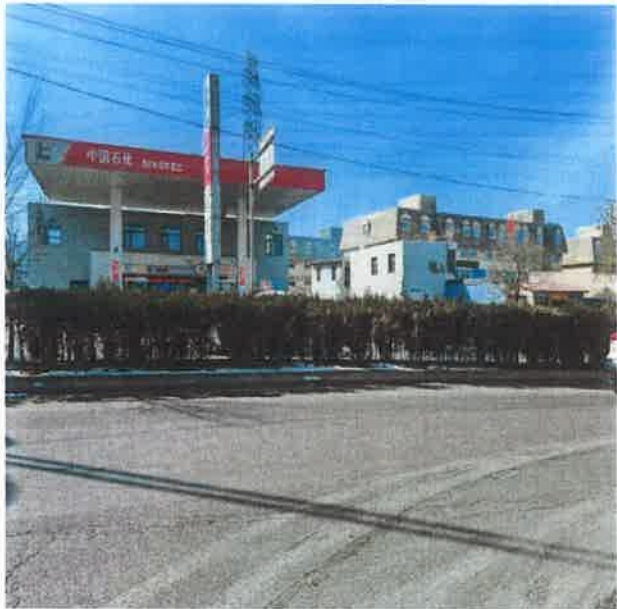
图 3 部分路段缺少隔离栏杆
