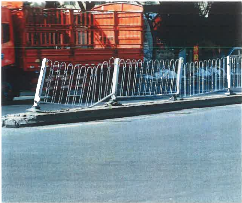
既有中分带隔离栏拆除后更换
