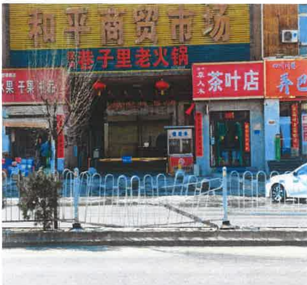
图 2 隔离栏杆变形
