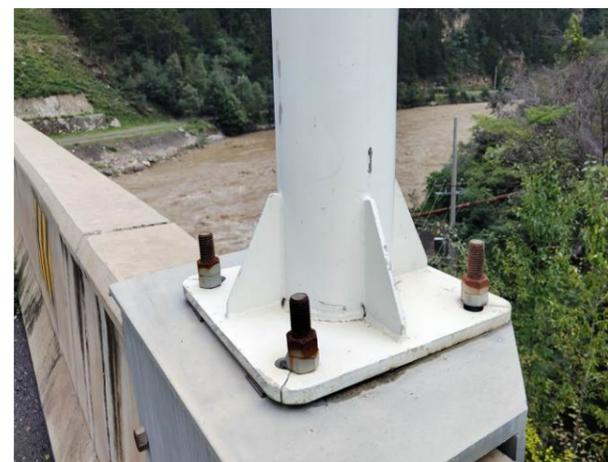
图 4.15 地脚螺栓锈蚀
