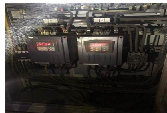
图 4.4 软启动器、接触器故障
