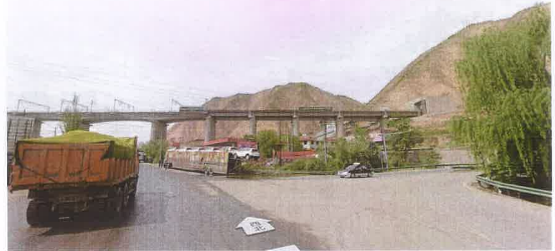
图 6-7 兰州北收费站（交警营房旁侧匝道）现状图
